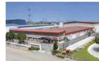
马来西亚工厂 NSK 微型轴承(M)工厂 吉隆坡，马来西亚
